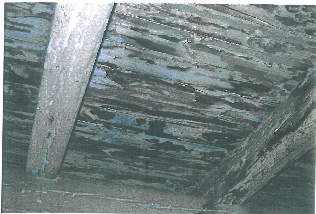
Fot. nr 8 Widoczne zawilgocenie ołoczenia połaci dachowej z desek w Budynku Gimnazjum
