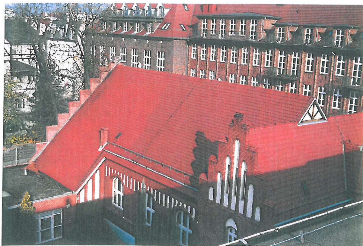
Fot. nr 2 Pokrycie dachówką ceramiczną budynku Sali gimnastycznej
