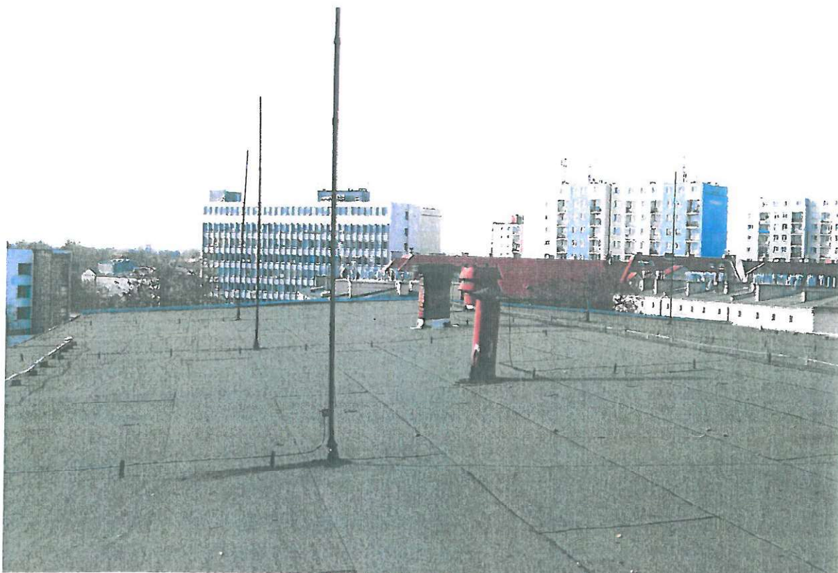
Fot. nr 5 Pokrycie papą termozgrzewalną Budynku Gimnazjum
