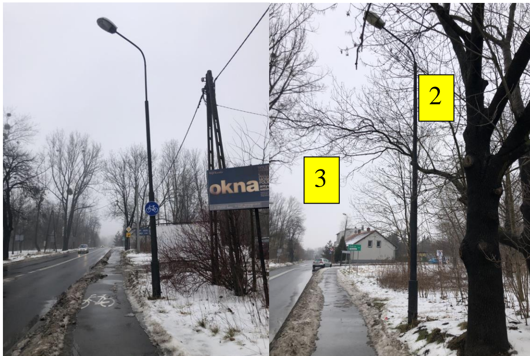
Słup nr 1 (stalowy z oprawą 9m)
