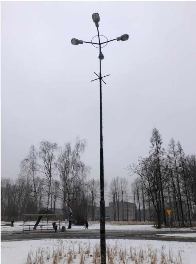
Słup nr 12 z wysięgnikiem czteroramiennym ( 4 oprawy) h =12m
