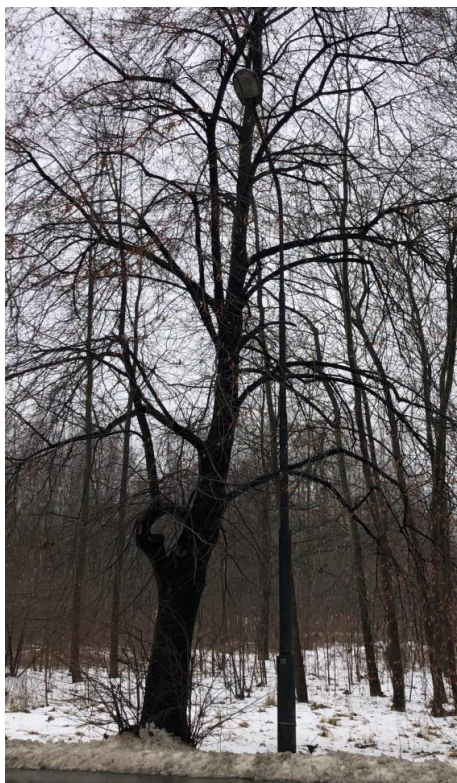
Słup nr 8 (stalowy z oprawą 9m)
