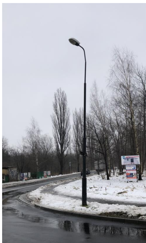
Słup nr 3 (stalowy z oprawą 9m)
