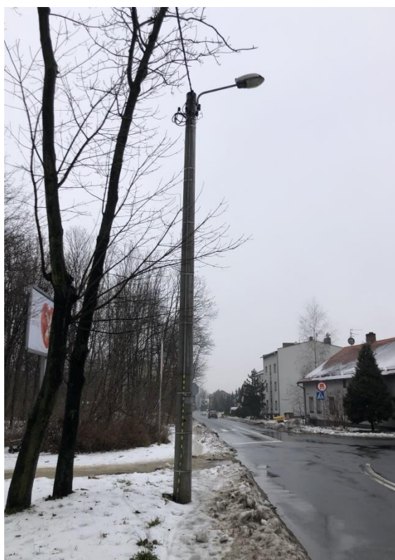
Oprawa na słupie betonowym
