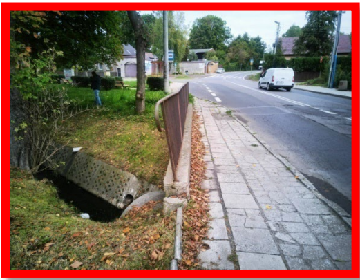
Fot. Okolica skrzyżowania z ulicą Rolników (strona prawa trasy widok w kierunku gminy Gierałtowie).
